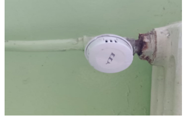
Resim 6. Termostatik Vana Renovasyonu – Öncesi ve Sonrası
