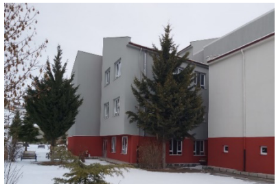
Resim 3. Bina Kabuğu (Öncesi ve Sonrası)
