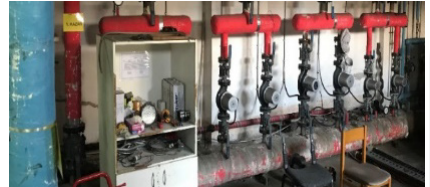
Resim 6. Termostatik Vana Renovasyonu – Öncesi ve Sonrası
