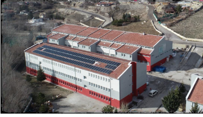
Resim 11. Çatı Üstü Fotovoltaik Güneş Enerji Sistemi (PV)
