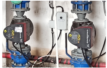
Resim 7. Sirkülasyon Pompası Renovasyonu – Öncesi ve Sonrası
